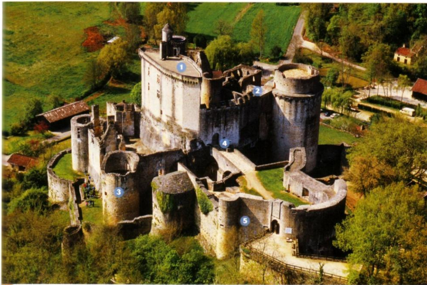
2 Fortifications du château de Bonaguil (Lot-et-Garonne), bâti dès le xiii^e siècle 1 Donjon, 2 créneau, 3 tour, 4 pont-levis, 5 mur d'enceinte.
